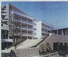
平成15年に建設された地下2階、地上6階建ての西館。中学3年生から高校3年生までが使用している
